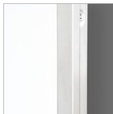
Przylga zabezpieczona profilem ze stali nierdzewnej
